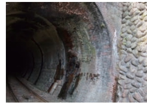
第二神土トンネル 坑門アーチ部分：長手積み
