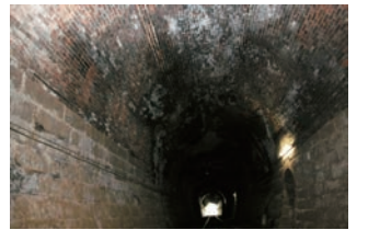
笠松トンネル 天井部分：長手積み 側壁部分：切石積み
