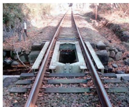
花輪駅と中野駅のほぼ中間地点、銅山街道旧花輪宿の面影を残す町並みの最も足尾側にある住宅の裏手にかけられた橋で、全長3.4mと短く、駅を出てから1分前後で通過してしまいます。長さ2.4mの橋桁はH鋼でレールを挟んだもので、トラフガーダー形式の橋です。
