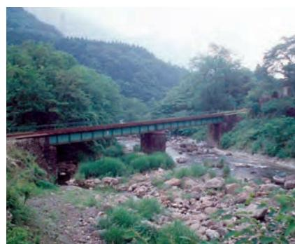
中野駅から下り線で約3分半で見えはじめます。駅からすぐ近くの国道122号線からも橋全体が見られます。全長40m、2連の橋桁が、2基の橋台と1基の橋脚にのる上路式プレートガーダー形式の橋です。橋台と橋脚は切石積みで、橋脚は木の葉形をしています。
