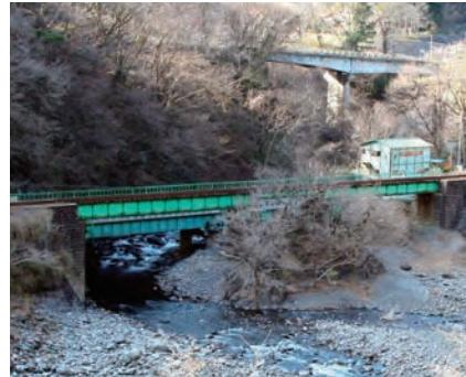
水沼駅から下り線で約3分、花輪駅から上り線で約2分半で見えはじめます。全長54m、上路式プレートガーダー形式の橋です。石積みによる大型の橋台と2基の橋脚が特徴で橋脚の断面は水の抵抗を減らすため、木の葉形をしています。北には銅山街道で栄えた旧花輪宿を望むことができます。
